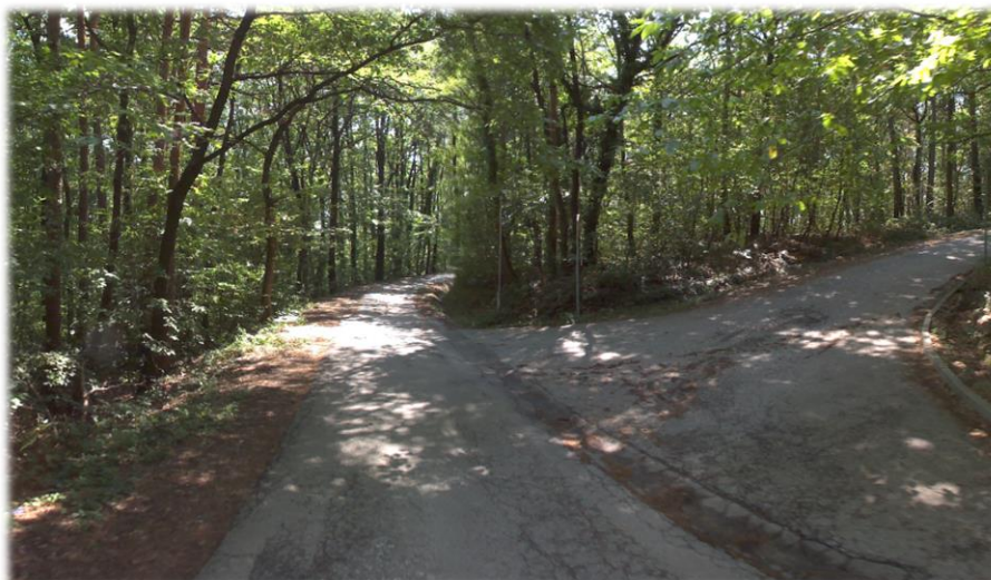
Slika 7: Odsek ceste Vodove ulice v križišču z Murščevo ulico
