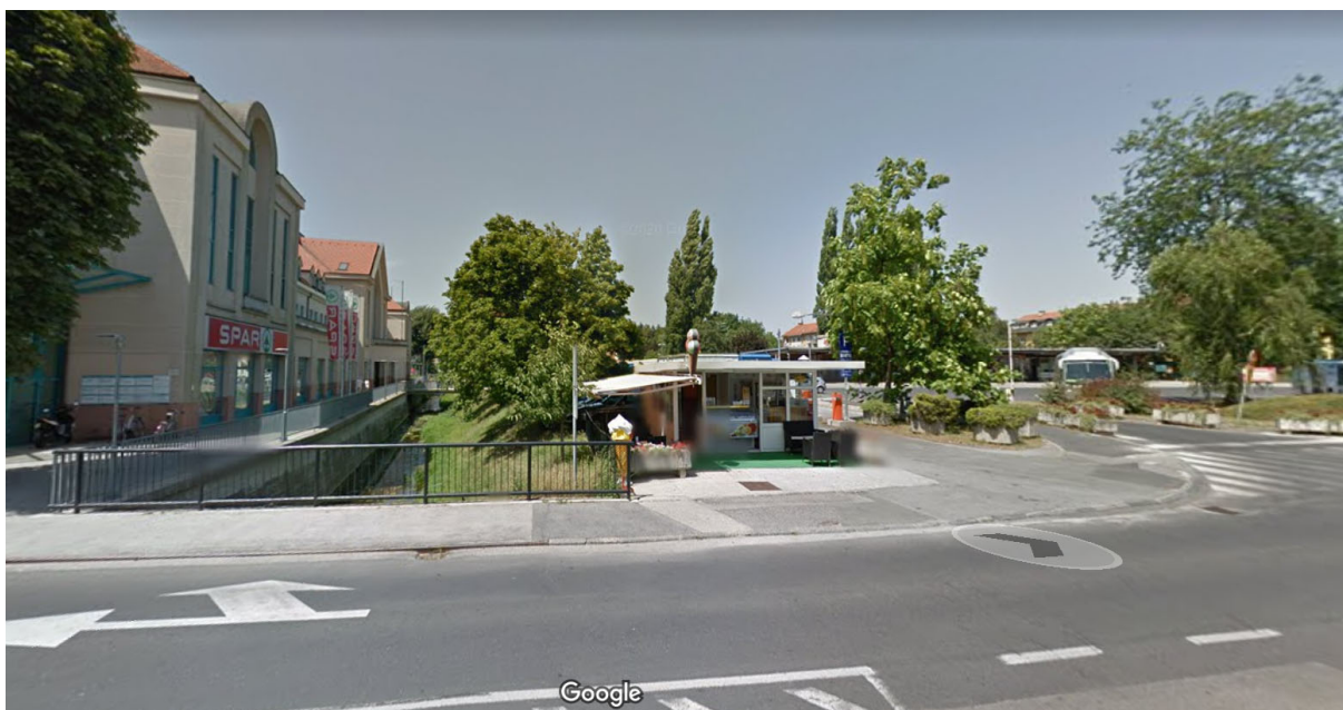
Slika 8: Pogled iz Osojnikove ceste proti zahodu na potok Grajena in avtobusno postajo
