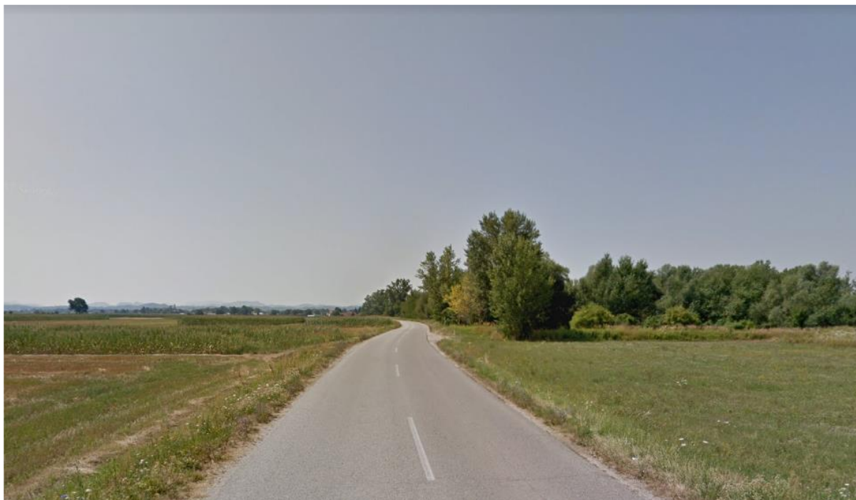
Slika 9: Lokalna cesta LC 328121
