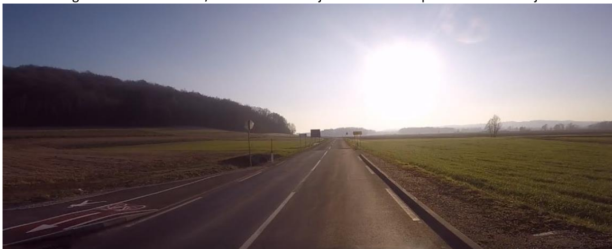
Slika 11: Regionalna cesta R3-712/1331 konec obstoječih kolesarskih površin skozi naselje Gabrnik
