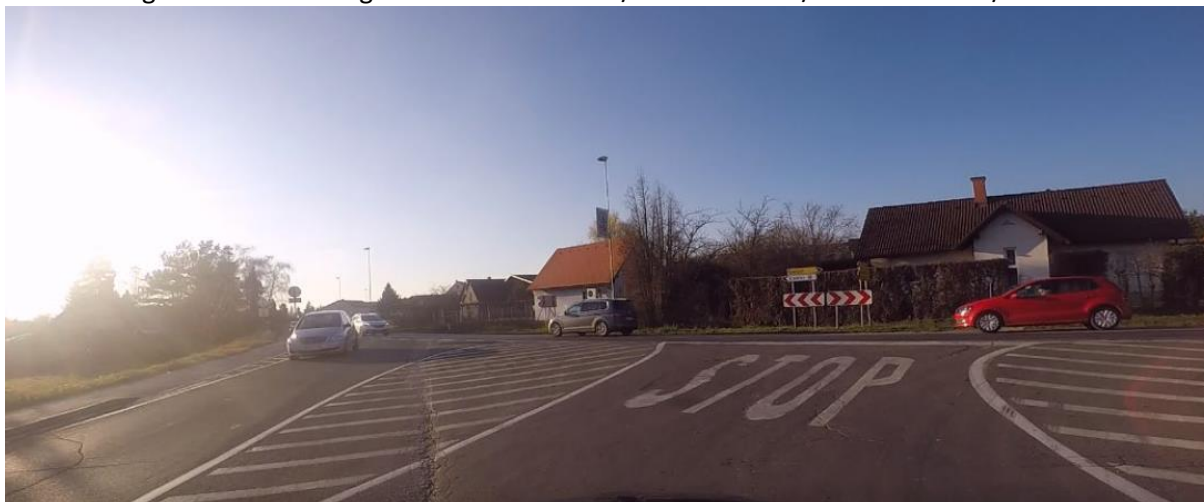
Slika 17: Pogled na križišče Regionalne ceste R3-712/1331 z R1-229/1417 in R1-229/1286
