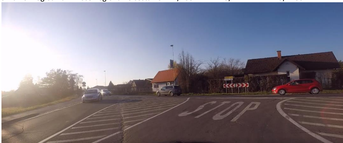
Slika 16: Pogled na križišče Regionalne ceste R3-712/1331 z R1-229/1417 in R1-229/1286
